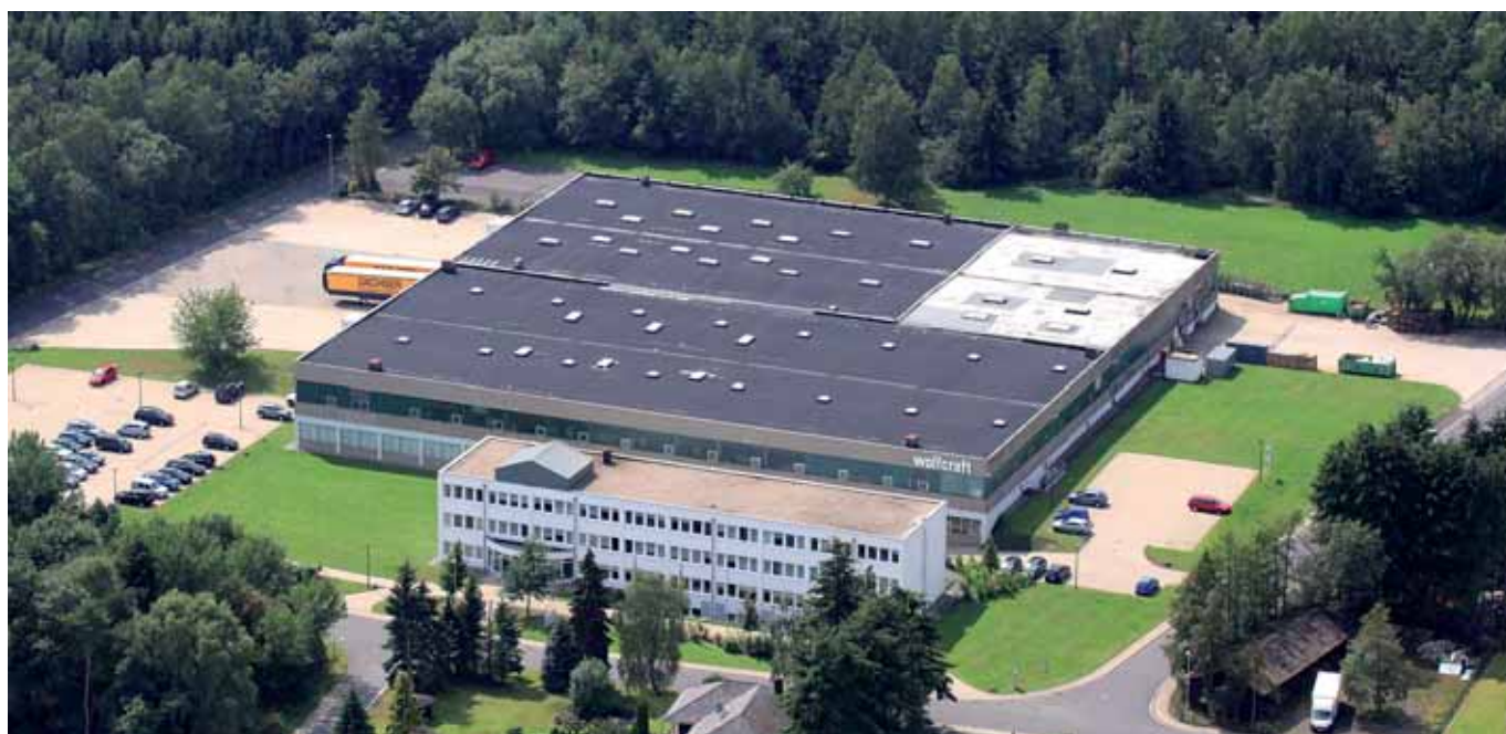
Siège administratif et centre logistique mondial de wolcraft GmbH basé à Kempenich en Allemagne
